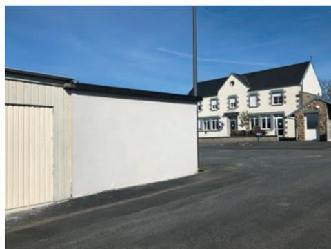
Suppression d'ouverture et enduit sur le garage communal
